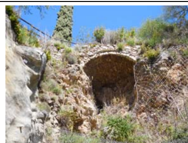
Arche dans le village, au-dessus de la RD 51, Parcelle AB 157
