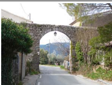
Aqueduc au village, surplombant la RD 51
