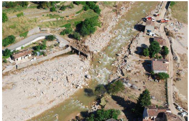
Photos 69 : La Nartuby à Rebouillon – Post Crue
