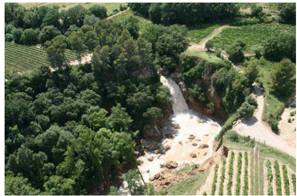
Photos 124 : Saut du Capellan - Vue post crue
