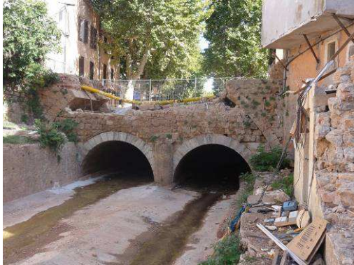
Photos 38 : Entrée actuelle et vestige de l'ancien pont, détruit lors de la crue – Le Réal aux Arcs
