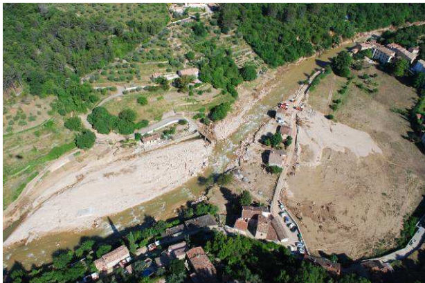
Photos 68 : La Nartuby à Rebouillon – Post Crue
