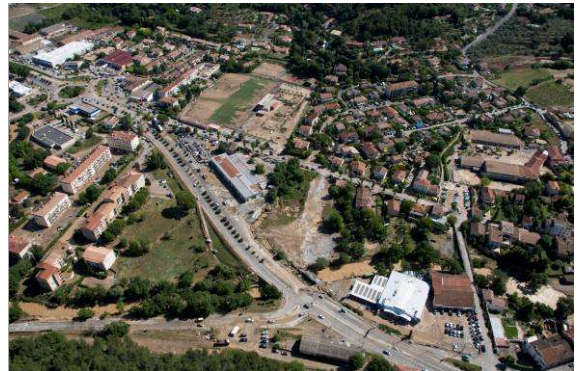
Photos 106 : Vue de la voie express et du Pont Vieux – Trans en Provence - vue post crue
