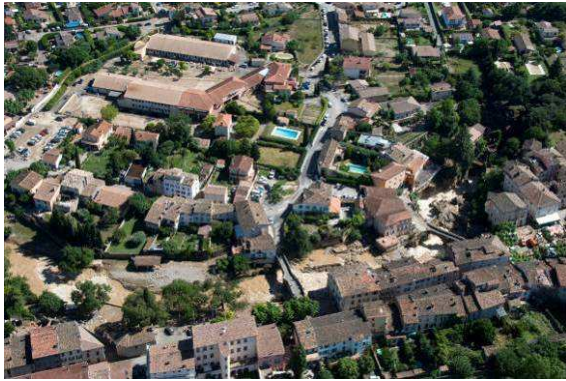
Photos 111 : Trans en Provence centre – Post Crue
