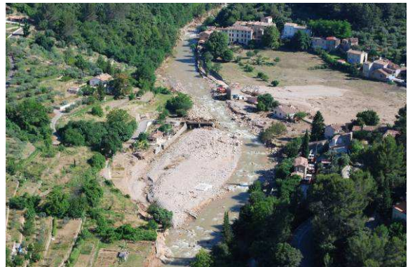
Photos 67 : La Nartuby à Rebouillon – Post Crue
