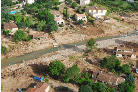
Photos 34 : Amont du Pont de la RD10 – Florièye à Taradeau - Post crue
