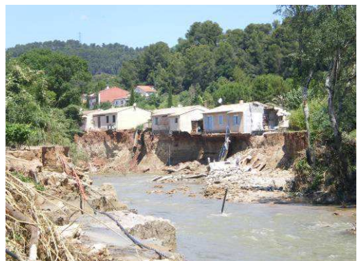
Photos 126 : Aval de La Motte – Érosion et mise en péril du Lotissement les hauts de la Nartuby
