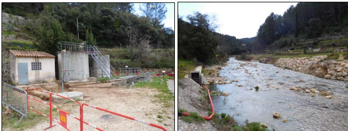
La station d'épuration de Rebouillon lors des travaux
