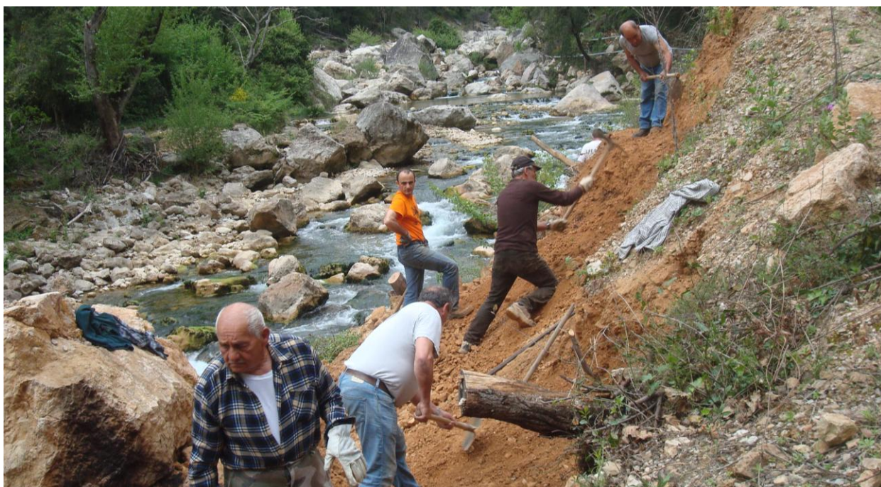
Les bénévoles à l'œuvre au début de la remise en état du canal
